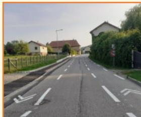
Le marquage de la voie centrale banalisée rappelle aux conducteurs la nécessité de ralentir pour se croiser, même s'il n'y a pas de vélos sur les côtés. Le radar pédagogique va être déplacé dans cette zone pour analyser les vitesses.
